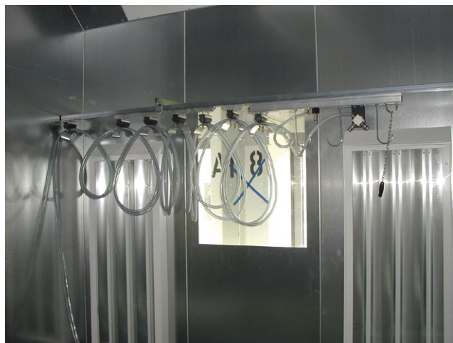
C-Schienebahn im Finishbereich einer Automobilproduktion
