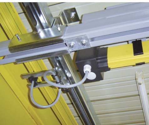
Kombinierte Zuverlässigkeit mit Kastenschleifleitungen an einem Gerätebrücke.
